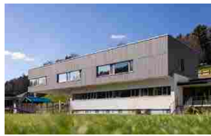
Neubau Kindergarten Naas
