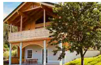
Einfamilienhaus T, Aigen im Ennstal
