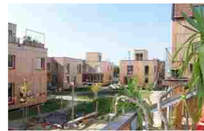
Wohn- und Reihenhausanlage Auenweide Wördern
