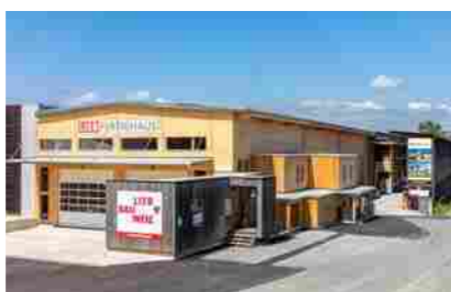
Erweiterung Produktionshalle und Neubau Bürogebäude Hartberg
