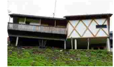
Zubau eines Schlacht- und Kühlraumes an ein Futterhaus für Farmwild
