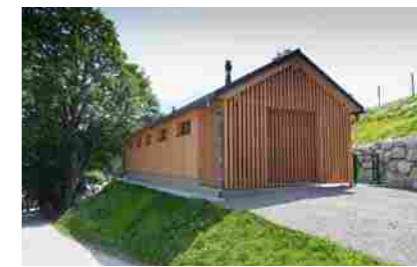
Campingplatz Aigen im Ennstal - Sanitärnebengebäude
