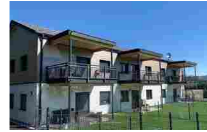
Sanierung Haus Burgstall 52
