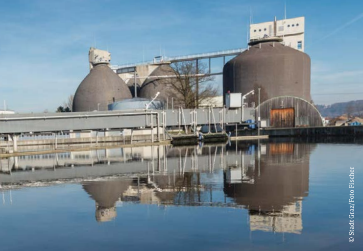
Faultürme der Kläranlage Gössendorf
