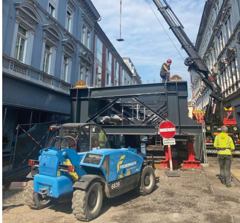
Die Stahlkonstruktion für den nördlichen Teil der Tegetthoffbrücke – in der Belgiergasse war ein Vormontageplatz eingerichtet.
